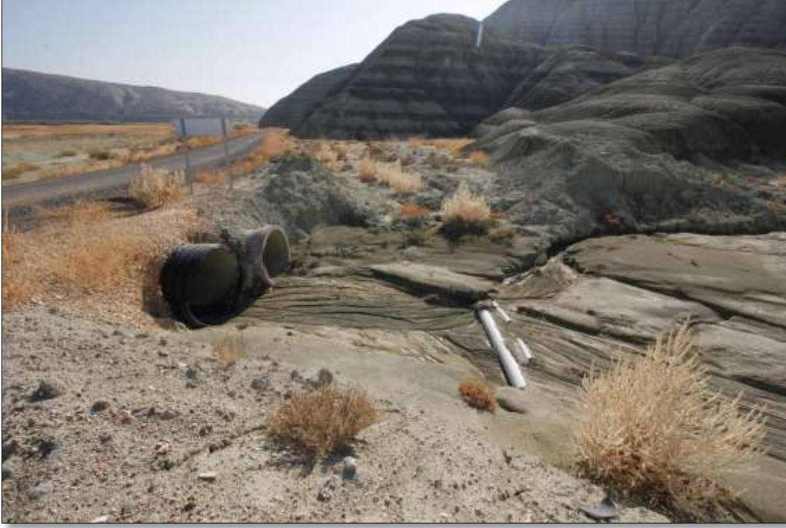
Şekil 23. Yol altında döşenen büz ve borular
