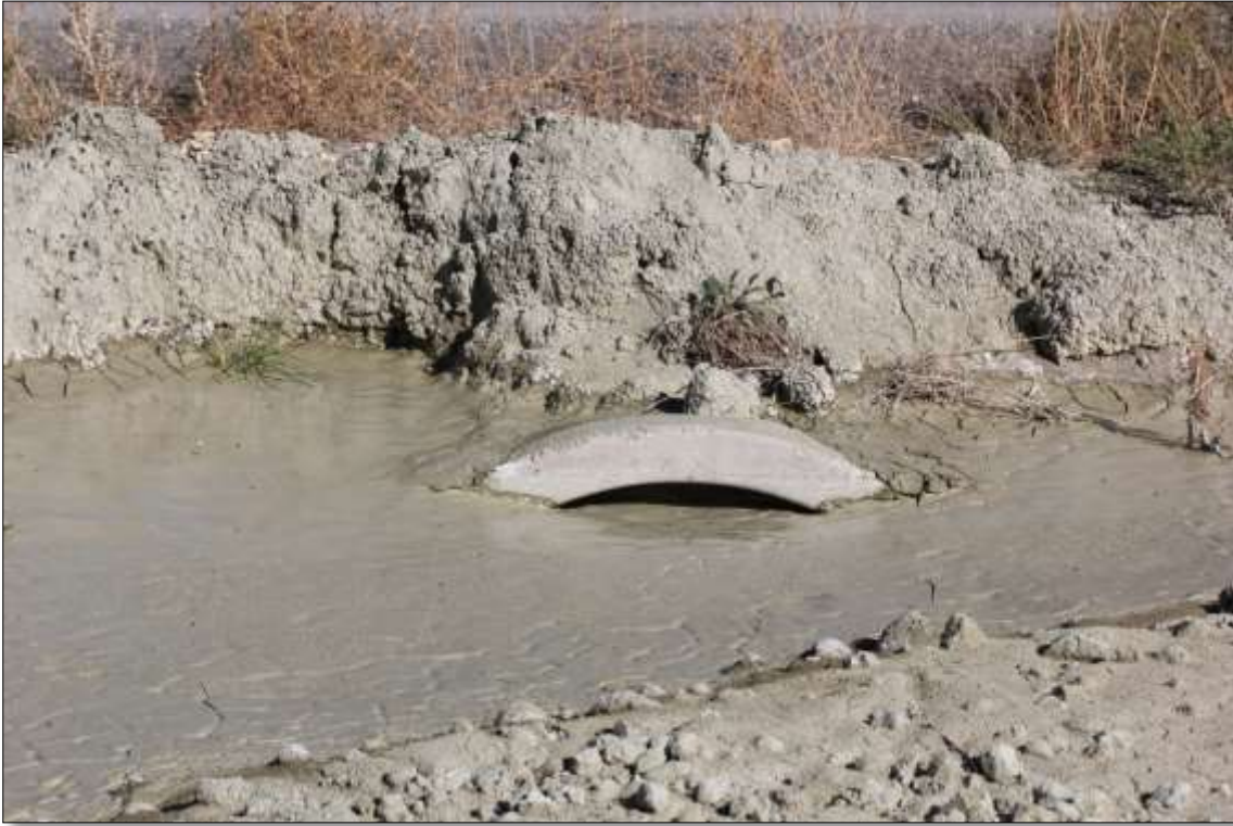
Şekil 24. Malzeme ile dolu büz
